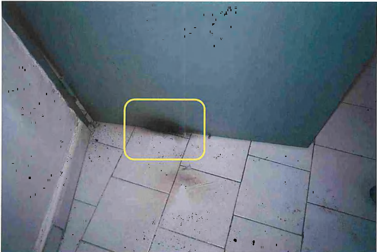
Vue de la position de la porte lors de l'explosion de la grenade à l'intérieur de l'appartement (porte en position ouverte)
