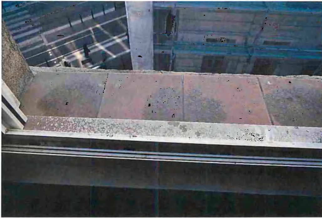
Intégrité de la plate-forme de la fenêtre
