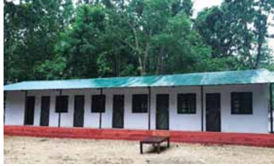
पोष्ट भवन निर्माण, आधाभार, पर्सा रा.नि.
